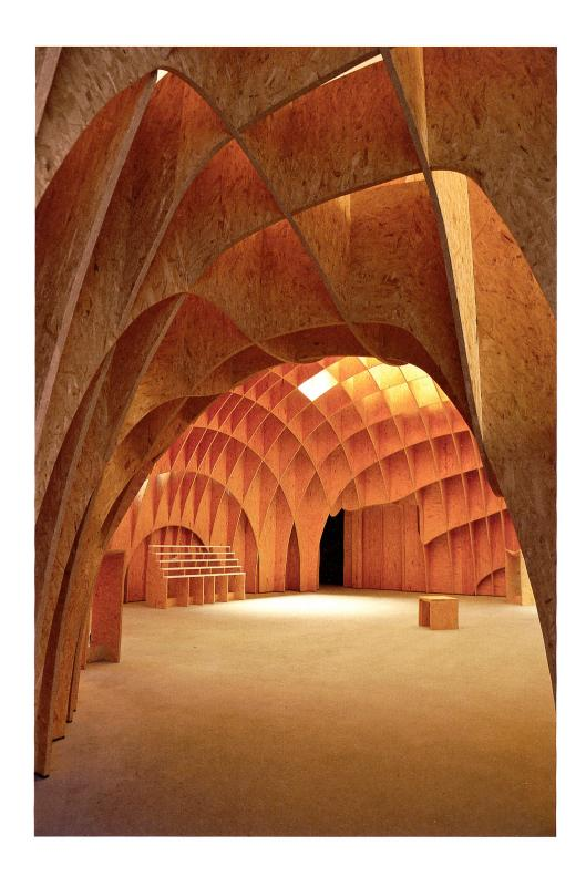
Im Kontrast zum scharf geschnittenen Äusseren zeigt sich der Innenraum als weiches Kuppelgewölbe aus Holz. Bild: Helen Schiffer
