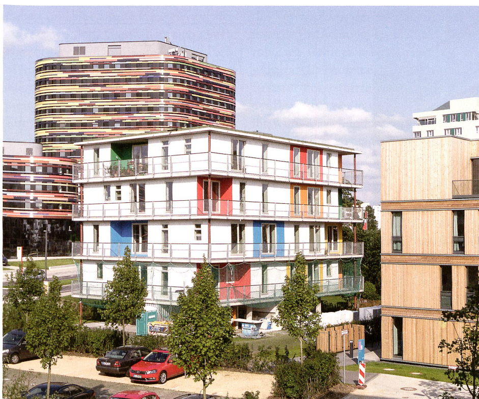
Hamburg-Wilhelmsburg: Das Haus zum Selbstausbau, ein Vorzeigeprojekt der IBA Hamburg, nennt sich «Grundbau und Siedler». In ein Betongerüst mit Erschließungskern und Stützen nisten sich die Bewohner mit individuellen Grundrissen ein. Bild: IBA Hamburg, Bernadette Grimmenstein
