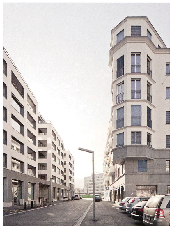
Strassenraum zwischen den Bauten von Adolf Krischanitz (links) und Hans Kollhoff (rechts); Blick vom zentralen «Rapid-Park» in Richtung Bahnlinie
