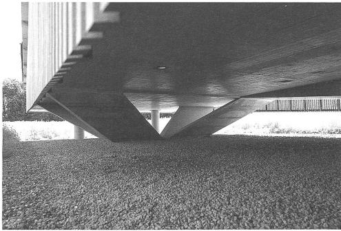
Zwei V-Stützen tragen die Beobachtungsplattform
