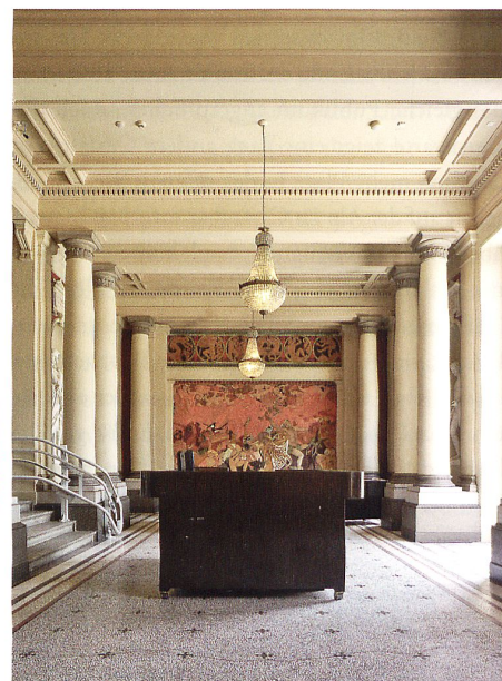
Renovierte Eingangshalle mit freigelegten Fresken und neuer mobiler Möblierung
