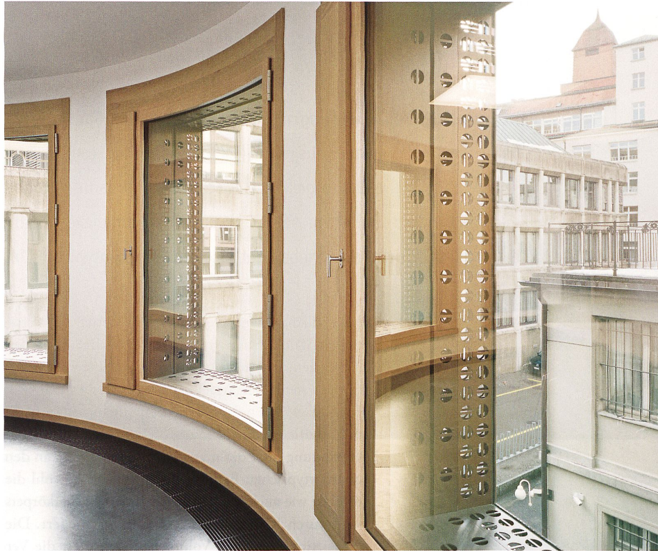
Tiefe, in Baubronze gefasste Fensterleibungen nehmen Bezug auf die feineren Profile der historischen Fenster.
