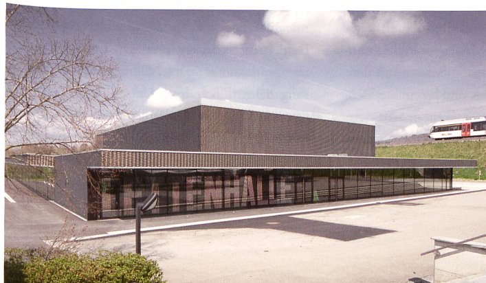
Die Halle mit «Fell» aus grossmaschigem Streckmetall
