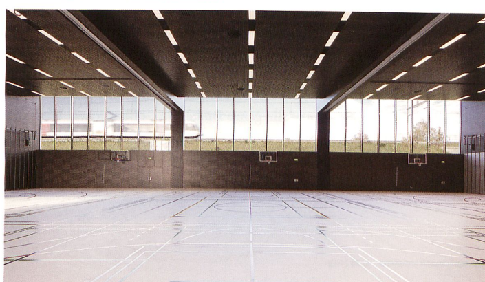
Nur zwei Trägerpaare tragen das Hallendach
