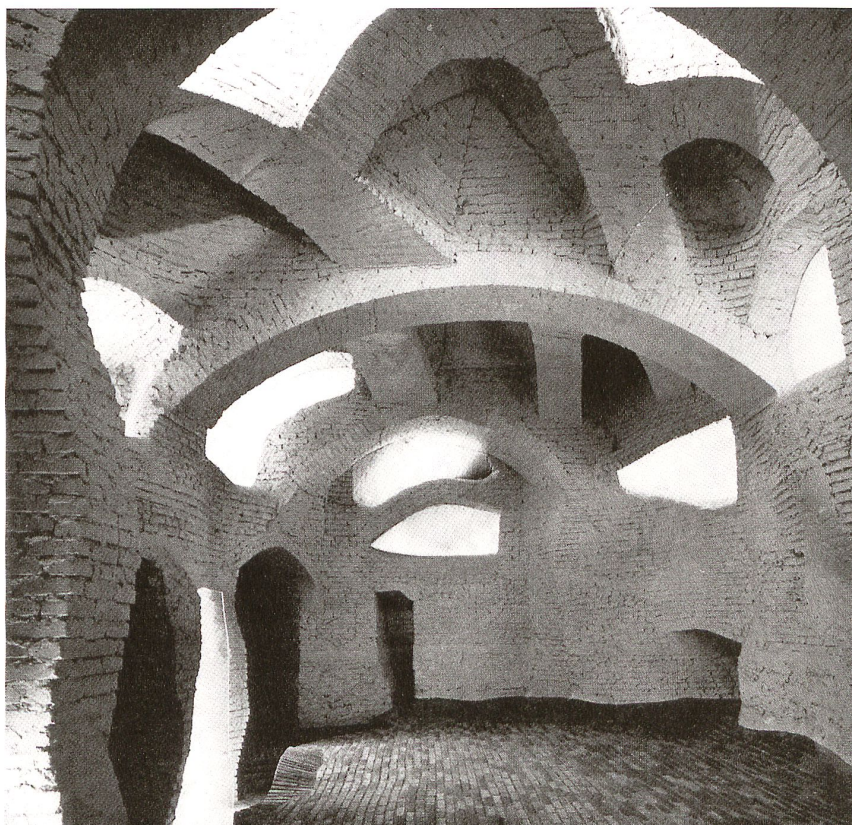
Innenraum und Konstruktion in Mischbauweise der sculpture habitacle II (1964). Bild: Aujourd'hui, Sondernummer 59-60, 1967, «André Bloc»
