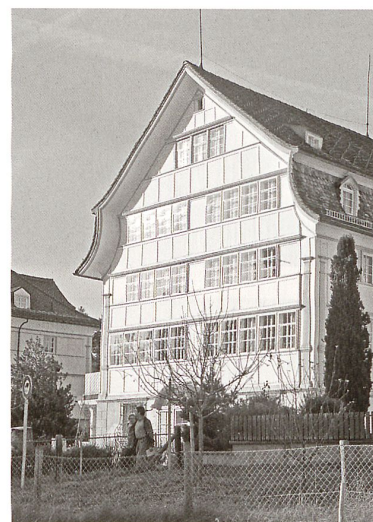
Ein barockisierendes und klassizistisches Bürgerhaus in Speicher, Appenzell Ausserrhoden. Die Fensterladenverkleidung des traditionellen Bauernhauses (Fensterwagen) bildet die Ausgangslage für die Stilisierung der gesamten Fassadenkomposition. – Bilder: Marco Teixeira-Duarte
