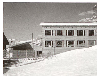
Kritischer Regionalismus: Schulhaus von Bearth & Deplazes in Alvaschein (1989) und Schulhaus von Conradin Clavuot in St. Peter (1998). – Bilder: Ralph Feiner
