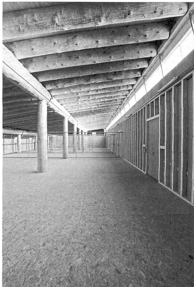
Du verre recyclé recouvre la toiture, vu de dessous (en haute). Vue sur les espaces de stockage (en bas). Photos: Fred Hatt
