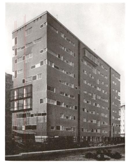
Die Fassade überspielt eine durchlaufende Pfeilerstruktur (Bild links), die Stützen werden zu Leibungen hinter Opalgläsern (Bild unten). Bild links: Roberto Aloi, Nuove Architetture a Milano, 1959, Bearbeitung Christian Sumi, Bild unten: Elli Mosayebi
