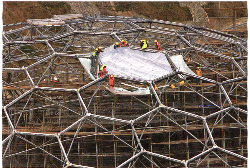
Fullers geodätische Kuppelkonstruktionen dienten ca. dreissig Jahre später dem Eden Project als Grundlage für die Konstruktion eines botanischen Gartens in Cornwall. Der Architekt Nicholas Grimshaw nutzte für die 30 000 m 2 grosse Hülle des Raumfachwerks Luftkissen aus ETFE. Bild: Simon Burt, Apex Photo Agency
