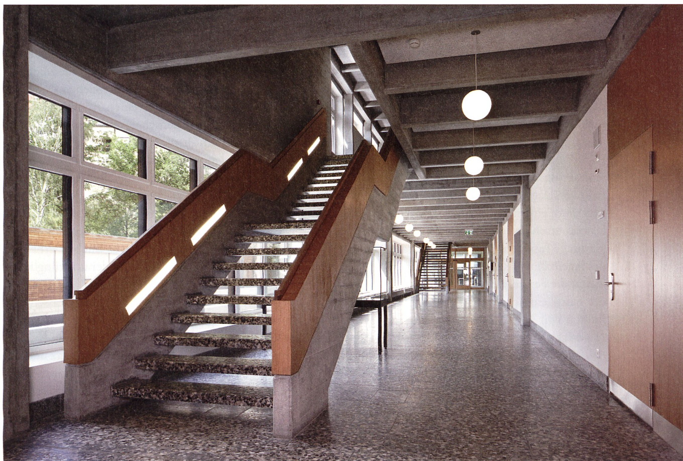
Im Treppenhaus wird die einfühlsame Adaptation des Bestandes greifbar. Die durch Vorschriften bedingte Aufdopplung der Treppenbrüstungen lässt diese noch körperhafter und gradliniger erscheinen als zuvor. Bild oben: Henn, Staatsarchiv Graubünden Chur
