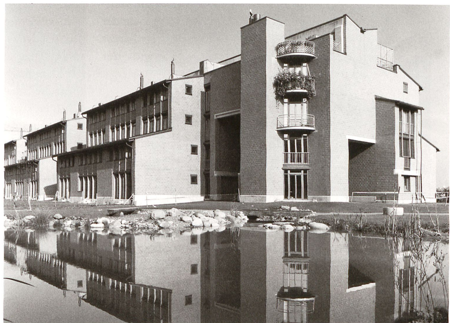
Nach Venturi – Sichtbackstein und dunkles Holz: Wohnheim der Stiftung Altried in Zürich- Schwamendingen von Werner Egli 1982 Bild: F. Maurer – Baugeschichtliches Archiv der Stadt Zürich
