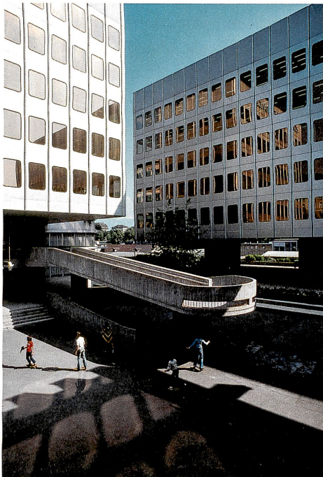
Vorhangfassaden und schwebende Volumen: Städtisches Verwaltungszentrum Chauderon von AAA – Atelier des Architectes Associés, 1969–1974 Bild: Ville de Lausanne
