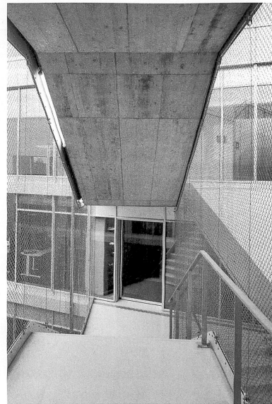
Treppenanlage in der Zwischenzone
