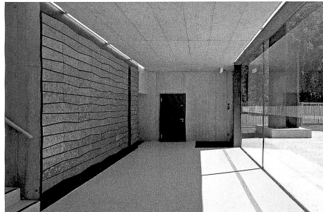
Eingangsbereich mit einer Kunstarbeit von Bruno Kaufmann (oben); Vorfahrt zur Einstellhalle der Feuerwehr, vorne rechts die Kommandozentrale, hinten der Schlauchturm (Bild rechts).
