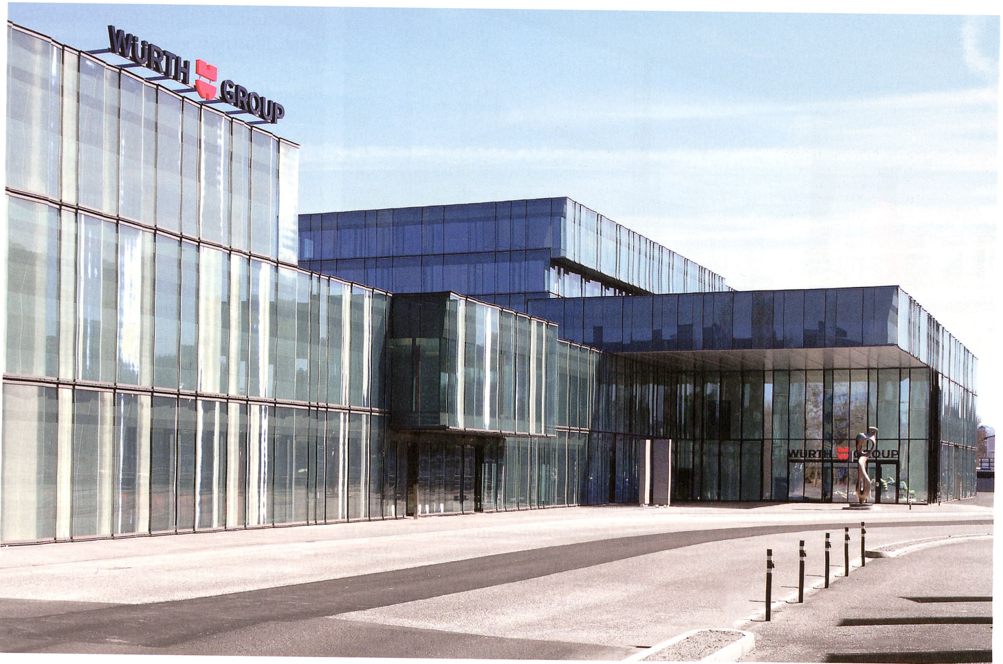
Hybrid aus Kongress- und Fortbildungszentrum, Verwaltungsbau, Heimwerkermarkt und Museum: Volumetrisch ausgebildete Eingangszone an der Churerstrasse.
