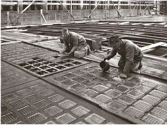
Glasbaustein früher: Für die Oberlichtverglasung der grossen Halle im Maschinenlaboratorium der ETH Zürich wurden die Glasbausteine einzeln in ein Stahlgitter eingelegt, verfugt und mit Blei vergossen. Bild: gta Archiv, ETH Zürich: Nachlass O. R. Salvisberg
