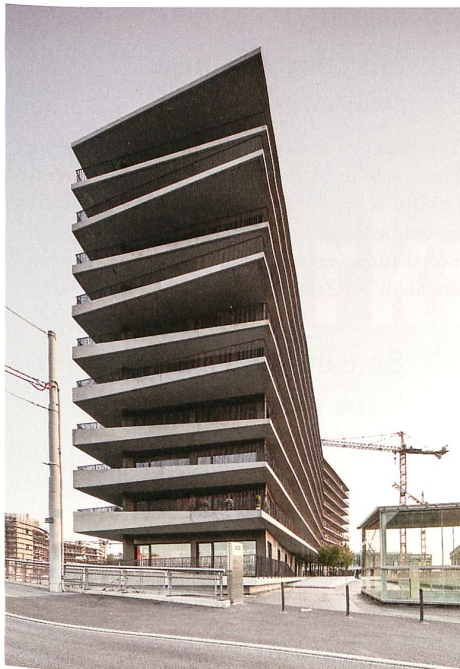
Einem bewegten Bretterstapel gleicht die Schmalseite des Studentenhauses, das Lacroix Chessex Architekten zeichnerisch an der Einfahrt zum Bahnhof Genf inszenierten. Bild: Radek Brunecky → WG mit Aussicht, Seite 34
