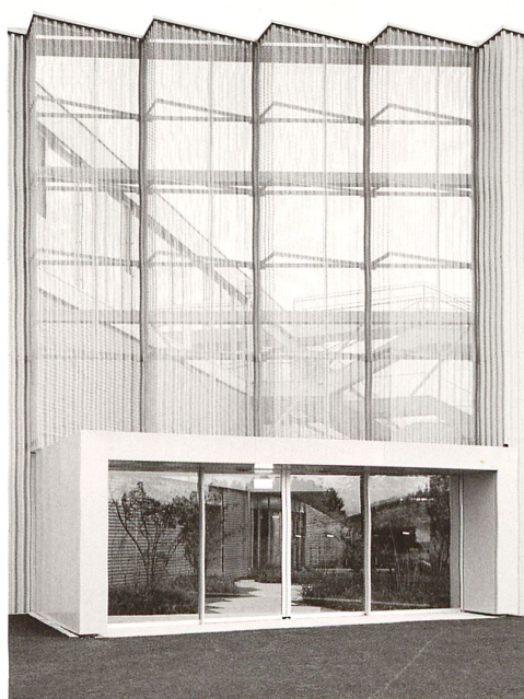
Homogene Hülle: Gelochte Aluminiumbleche umgebenden ganzen Baukörper (oben) Eingang zum «inneren Garten» zwischen Büro- und Hallenbau.
