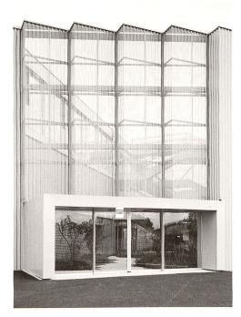
Homogene Hülle: Gelochte Aluminumbleche umgebenden ganzen Baukörper (oben) Eingang zum «inneren Garten» zwischen Büro- und Hallenbau.
