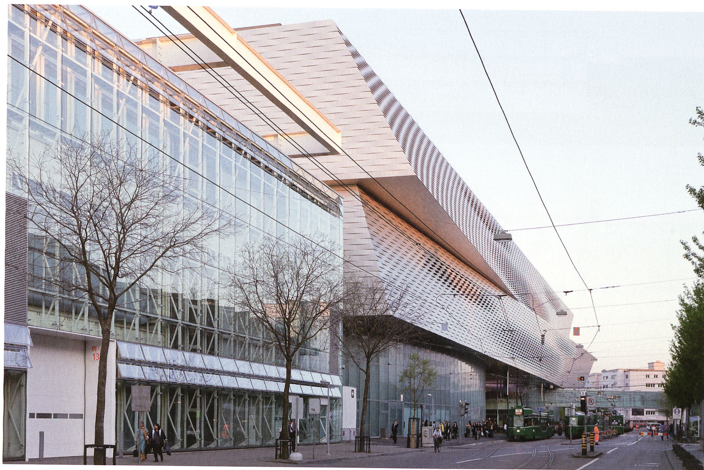
Das enorme Volumen der neuen Hallen ist durch verschiedene Massnahmen belebt und gegliedert: Die Hallen sind in der Achse leicht verschoben, die Aussenwände wechselnd geneigt, und die Fassade wölbt sich über Fenstern und Lüftungseinlässen.
