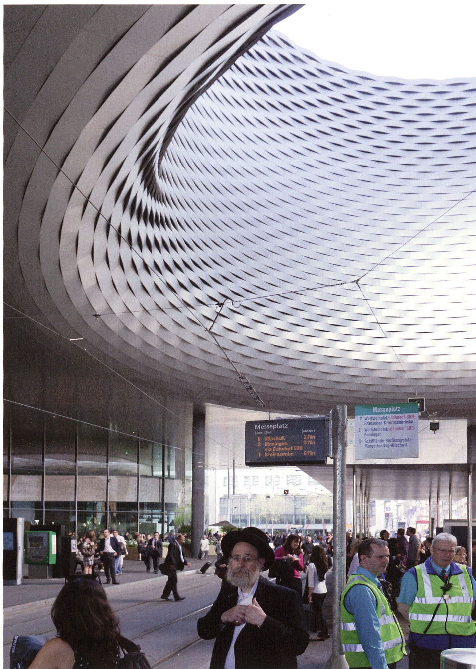
Hochbetrieb an der Uhren- und Schmuckmesse. Der kranzförmige Ausschnitt in der Mitte der Halle bringt Tageslicht in die Tiefe des Messeplatzes und erinnert an die benachbarte Rundhofhalle von Hans Hofmann.
