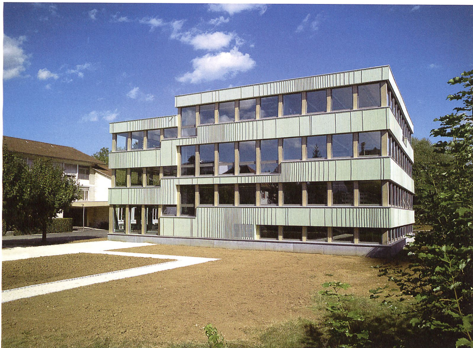
Erweiterung des Collège de Delémont von GXM Architekten, Zürich
