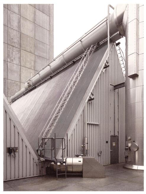
Anschauliche Technik ohne bildhafte Metaphern: Der heisse Dampf wird über steildachähnliche Luftkondensatoren geleitet und zu Wasser kondensiert.
