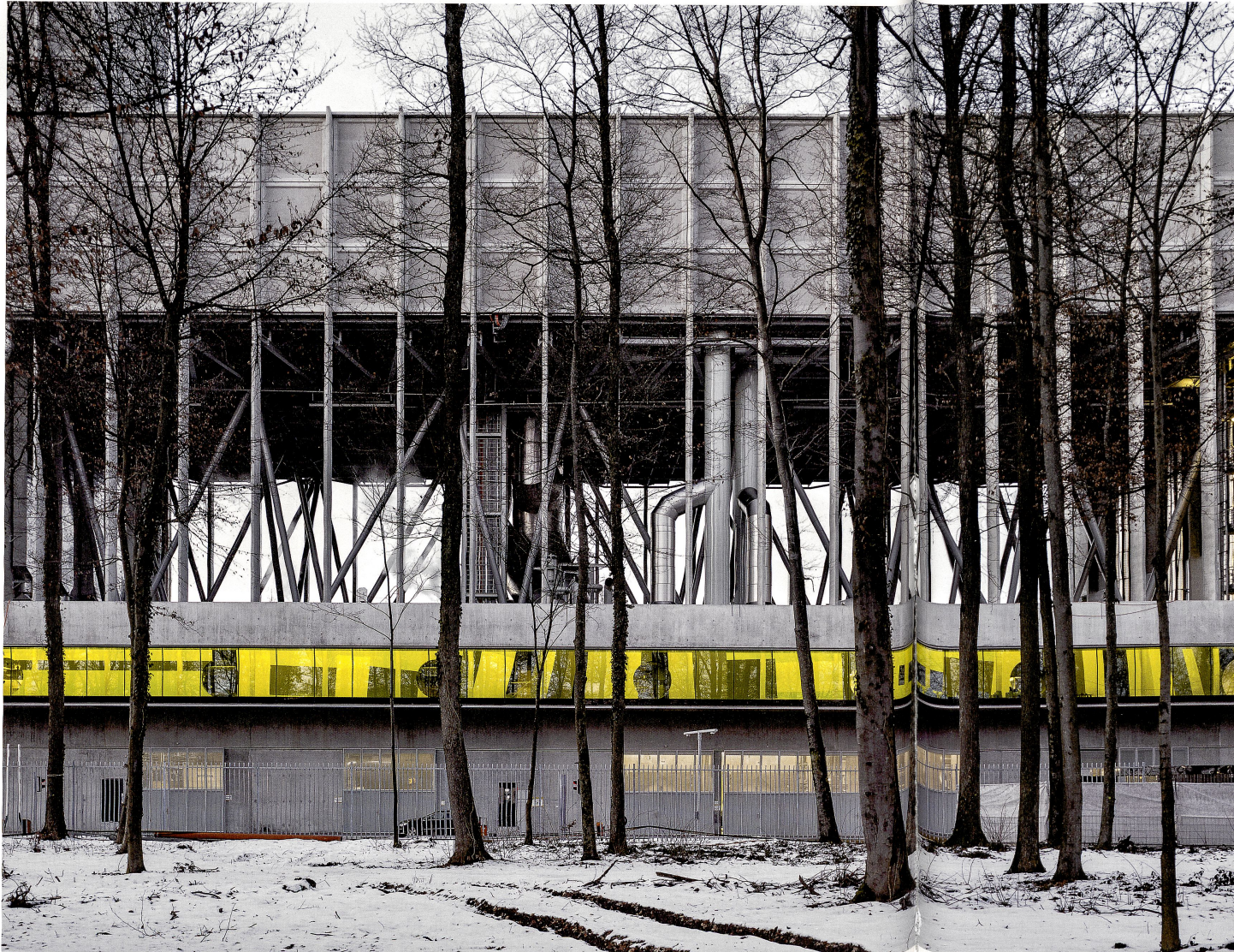
Maschine im Wald: Der Baukörper der Energiezentrale liegt in einer eigens gerodeten Lichtung. Fassade und Konstruktion der Grossform sind in ein modulares System von Betonelementen aufgelöst.
