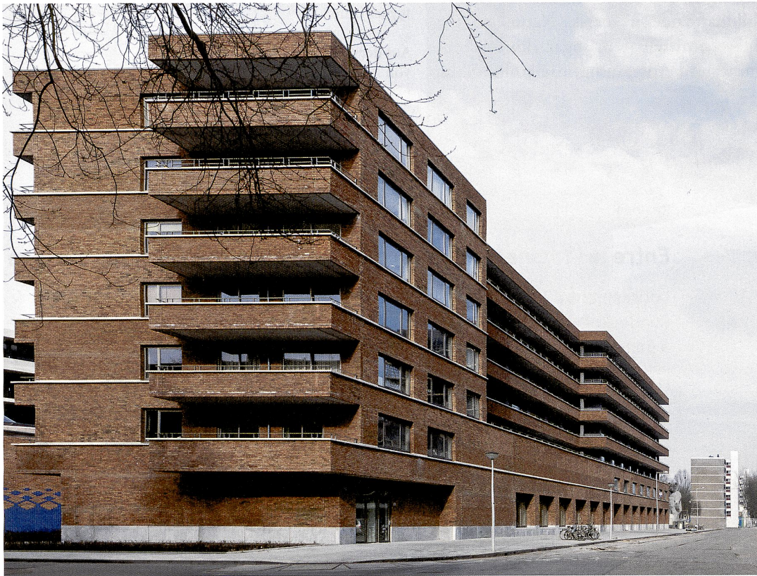
Eine Moschee (Bild oben), ein Kindergarten sowie eine Schule mit Sportanlage bilden zusammen mit dem Wohnblock ein neues Ensemble im Nachkriegsquartier.
