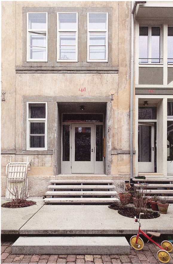
Die 2012 zum Wohnen umgebauten Häuser an der Basler Reichensteinerstrasse 14 von Kräuchi Architekten mit dem Landschaftsarchitekten Pascal Gysin bestechen mit gestuften Übergängen: Treppen, Terrasse und Türnischen sowie die Markierungen durch die Bepflanzung erleichtern die Aneignung durch die Bewohner.
