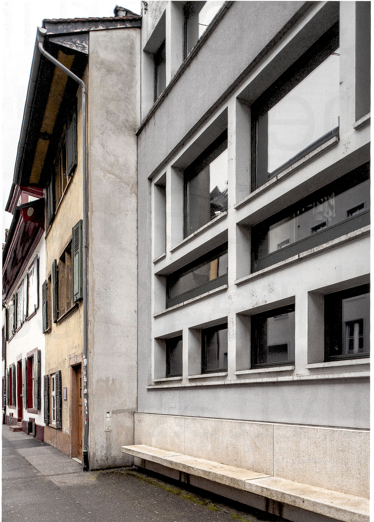
Die Sitzbank als Metamorphose eines Sockels ist eine Einladung an die Besucher, sie meistert die materiellen und funktionalen Übergänge am Verwaltungsgebäude Manor (1990) in Basel von Diener & Diener.
