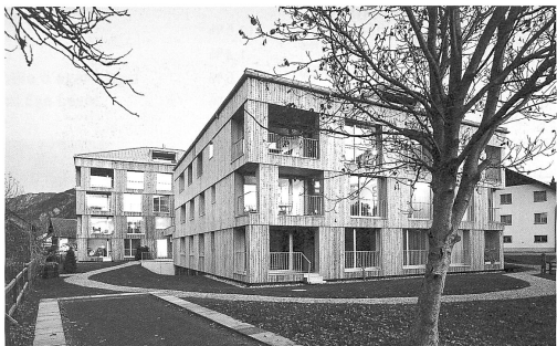
Ansicht von Westen
