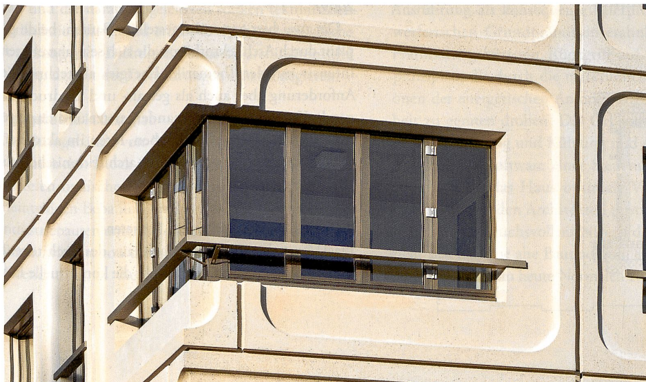
Die vorfabrizierten tragenden Betonelemente wurden geschossweise versetzt und mit den Deckenstirnen kraftschlüssig ausbetoniert. Die Sandwichelemente wirken als Rahmen. Sowohl Stoss- wie Lagerfugen sind überlappend ausgebildet, so dass auf sichtbare Silikonbänder verzichtet werden kann. Die Fuge erhält als grosszügiges Schattenband eine gestalterische Wichtigkeit in der gesamten tektonischen Formulierung und unterstützt bis in die Nahbetrachtung die starke Plastizität im Ausdruck des Gebäudes. – Bild: Jürg Zimmermann
