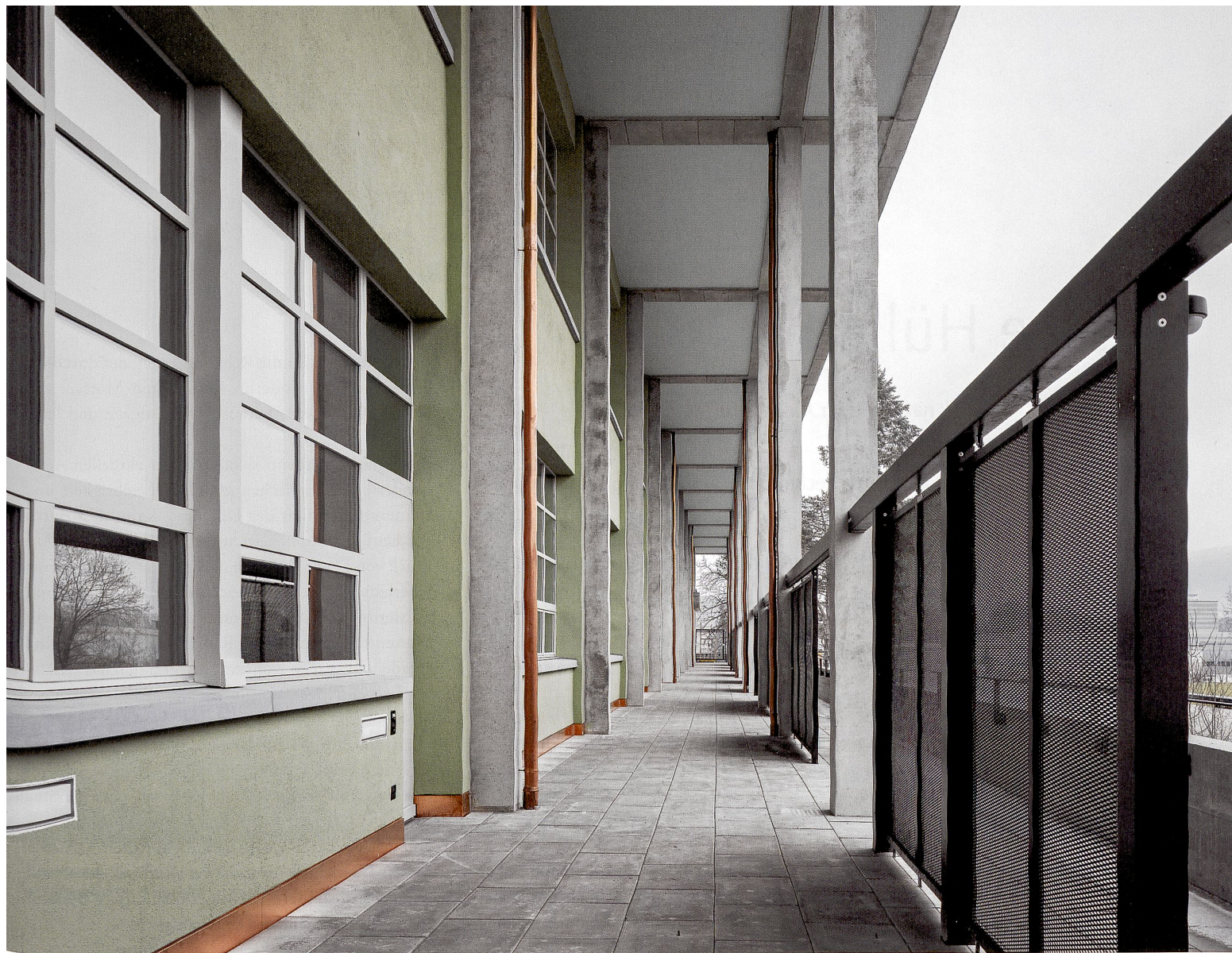
Laubengang im 1. OG mit Sichtschutz aus Streckmetall
