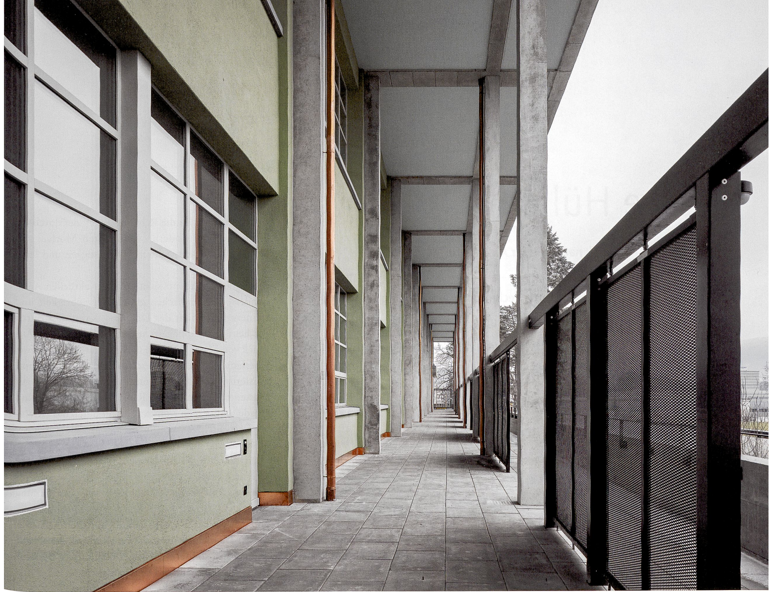
Laubengang im 1. OG mit Sichtschutz aus Streckmetall
