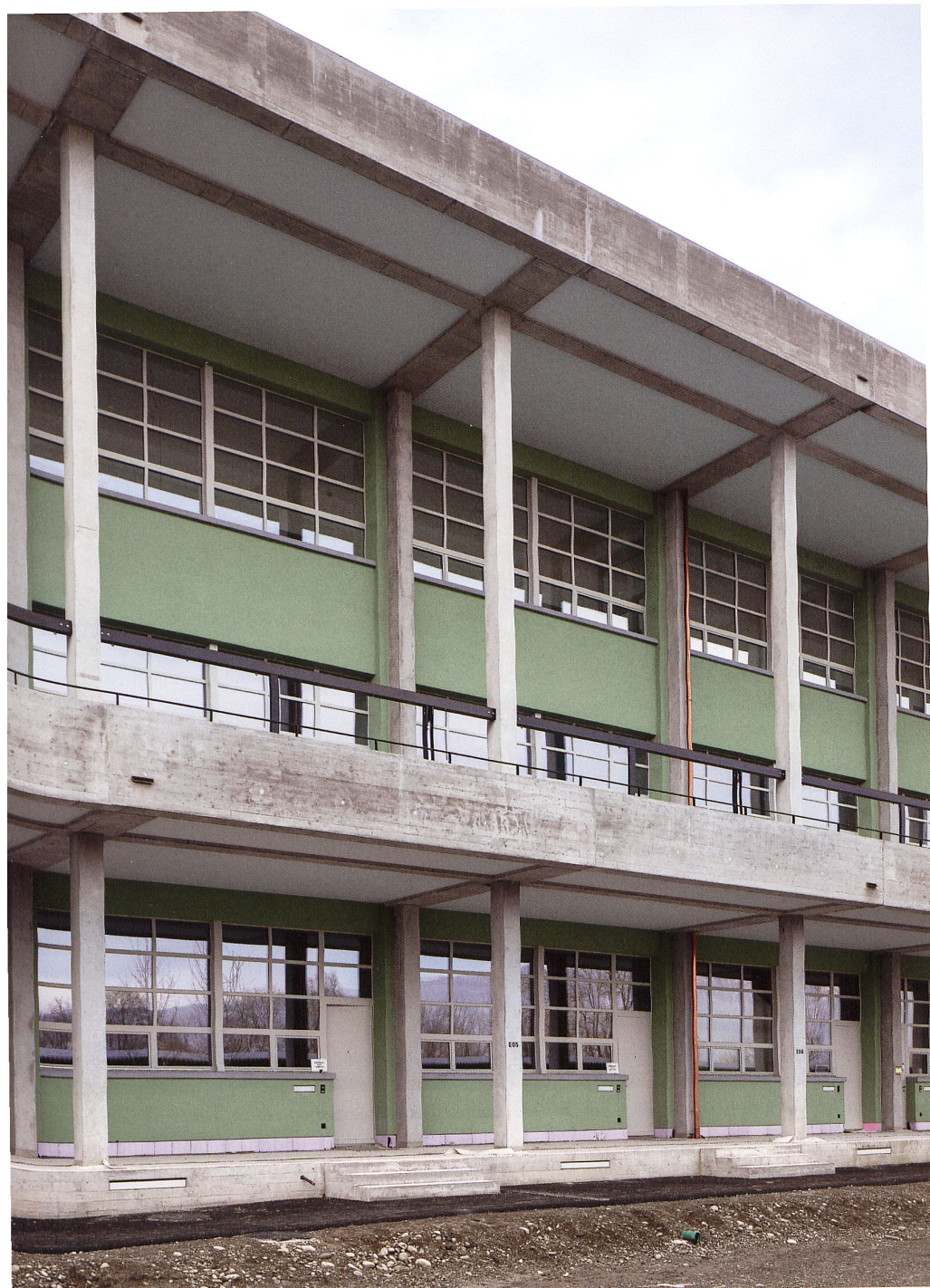
Raumartige Erschliessungsschicht als Identitätsträger: Laubengänge an der Nordfassade
