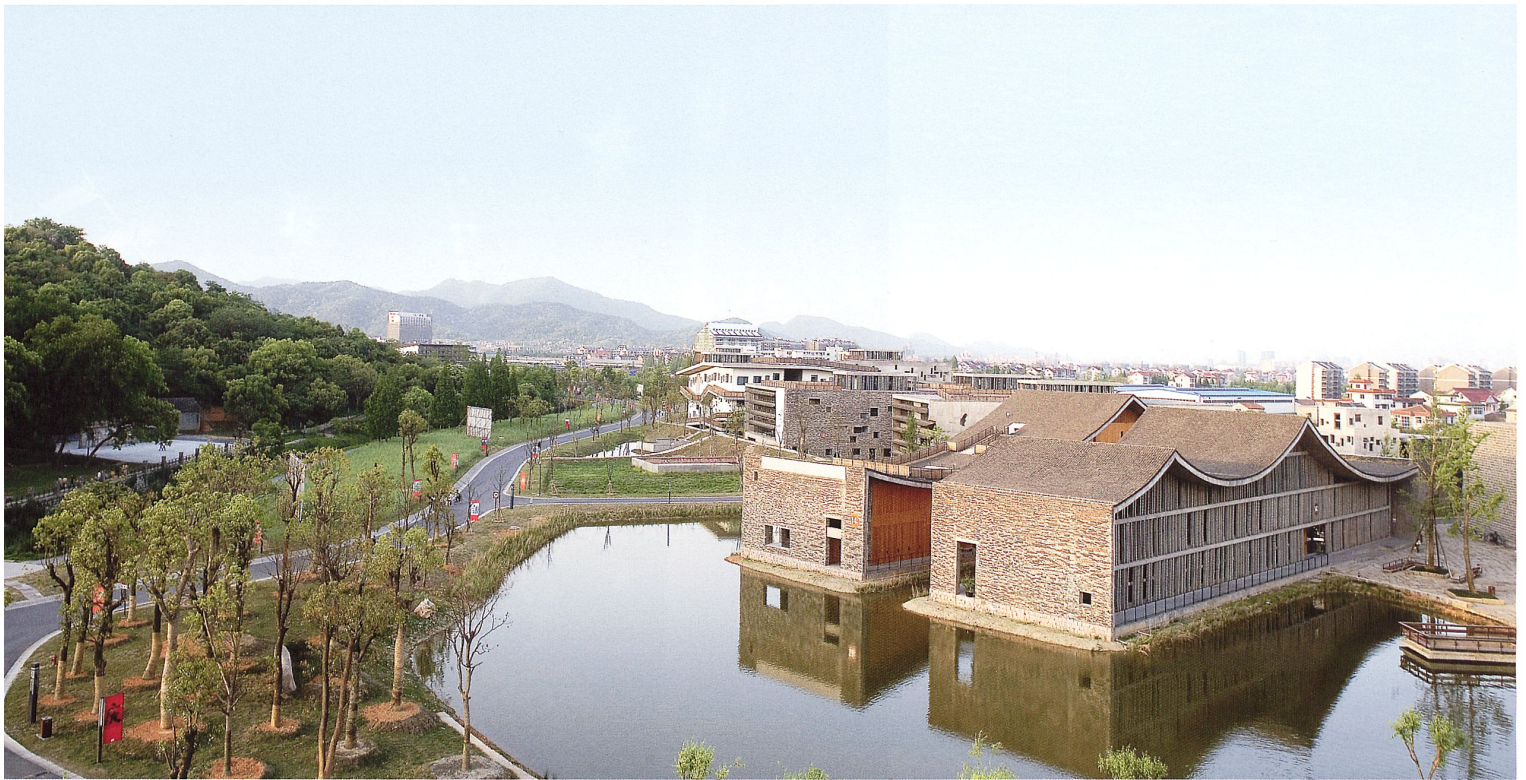
Die Bauten auf dem Xiangshan-Campus der Kunstakademie (2004–07) liegt in idyllisch gestalteter Parklandschaft. Es schwingen Anklänge an traditionelle Dachformen mit, die chinesische Kritiker für manieriert halten. Die Holzläden dienen der Verschattung der Ateliers.
