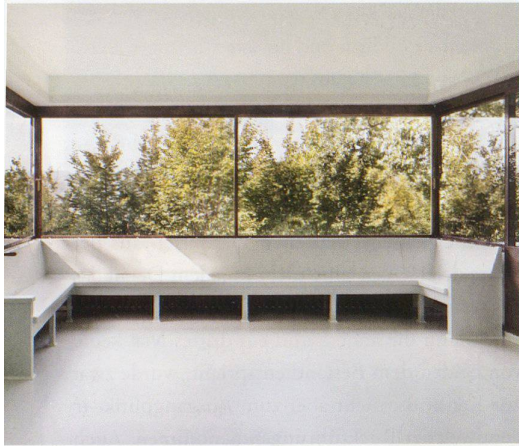
Die über Eck gezogenen Fenster, oft präzise auf Einbaumöbel abgestimmt, prägen die Aussicht nach Süden. Die Eingangsseite hingegen weist eine Lochfassade auf, die Nutzräume wie die geschwungene Treppe belichtet.
