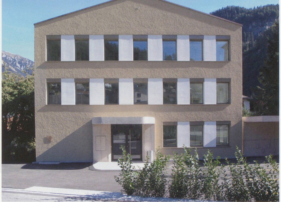
Kompakter Baukörper als Solitär an der Strasse
