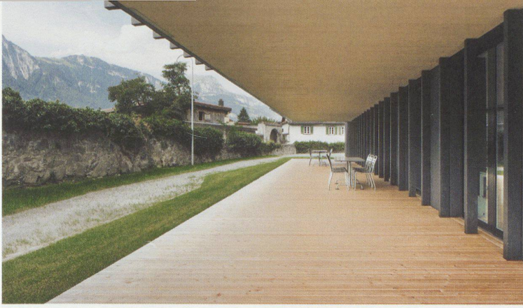
Gedeckte Terrasse im Erdgeschoss
