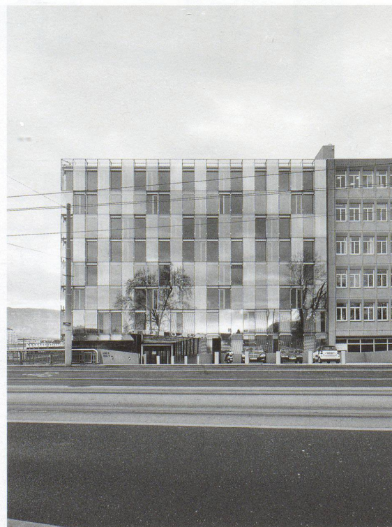
Façade donnant sur l'Avenue de France
