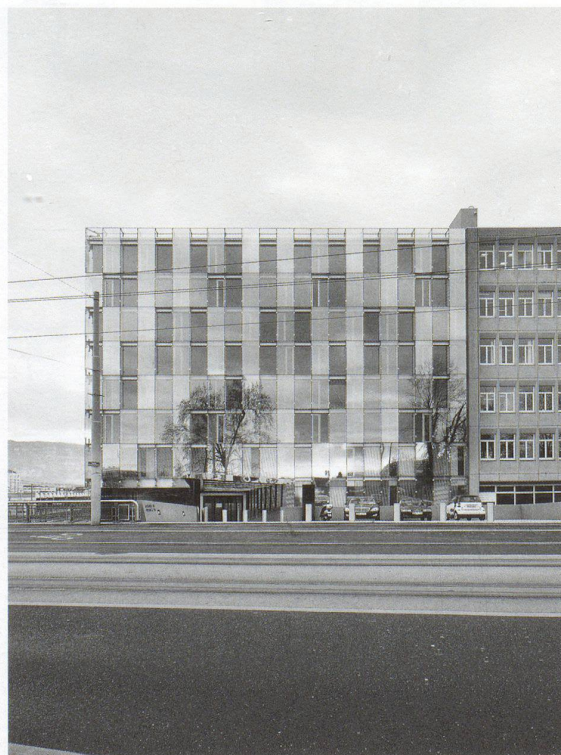
Façade donnant sur l'Avenue de France
