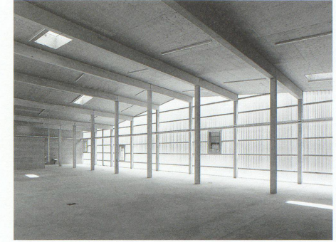
Halle froide avec simple peau en polycarbonate
