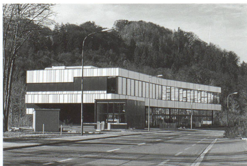
Ansicht von der Schlosstalstrasse
