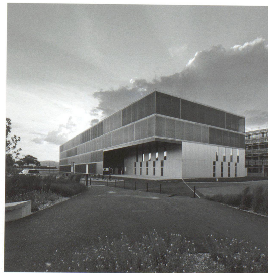
Vue générale depuis l'entrée principale
