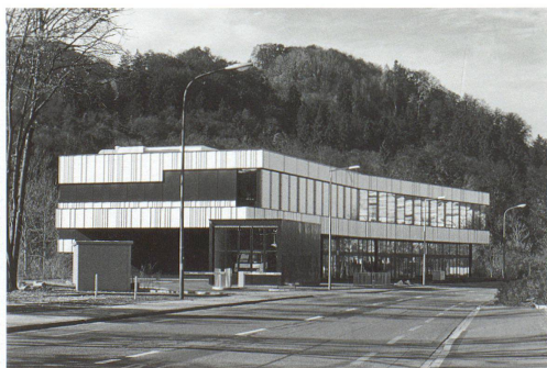
Ansicht von der Schlosstalstrasse
