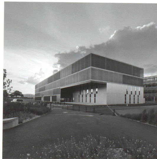
Vue générale depuis l'entrée principale
