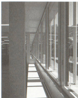
Fassade und zurückgesetzte Stützen
