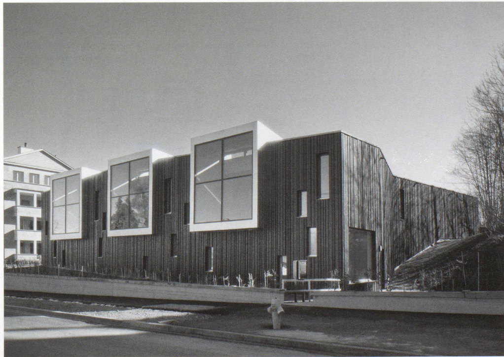
Ansicht von der Brechbühlerstrasse
