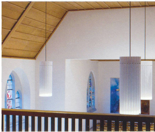
Neue Beleuchtungskörper an der gebrochenen Bretterdecke; an deren Übergang zu den innen isolierten Wänden neu formulierte Anschlussdetails
