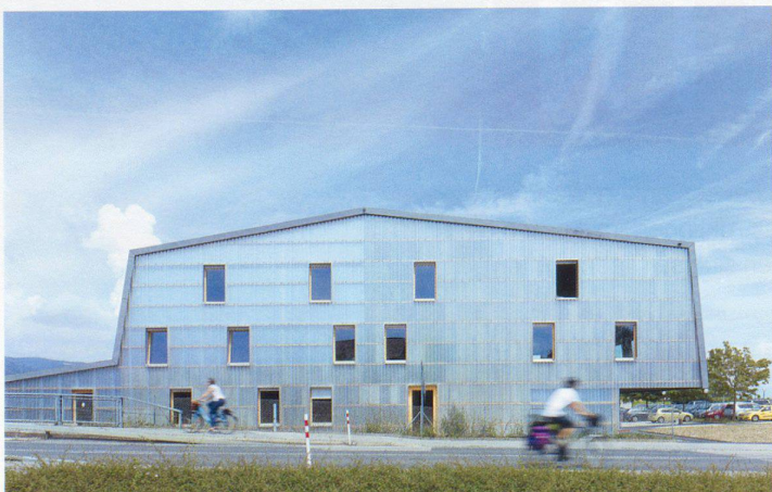
Einem Tier gleich, liegt der Körper mit Polycarbonathaut an der Dorfstrasse (links). Maschinenhalle (rechts)
