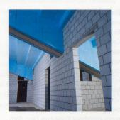
rund 240 Franken mehr zu bezahlen. Den Schallschutz bei einem Neubau durch das Verwenden von Kalksandstein gleich einzubauen, ist wesentlich wirtschaftlicher als die nachträgliche Abschirmung oder Absorption von Lärm. Eine überlegte Grundrissplanung ist der einfachste und günstigste Schallschutz.
