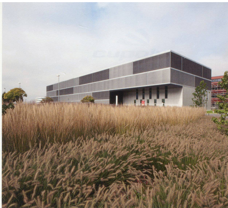
Abstrakte Fassade durch umlaufenden Sonnenschutz
