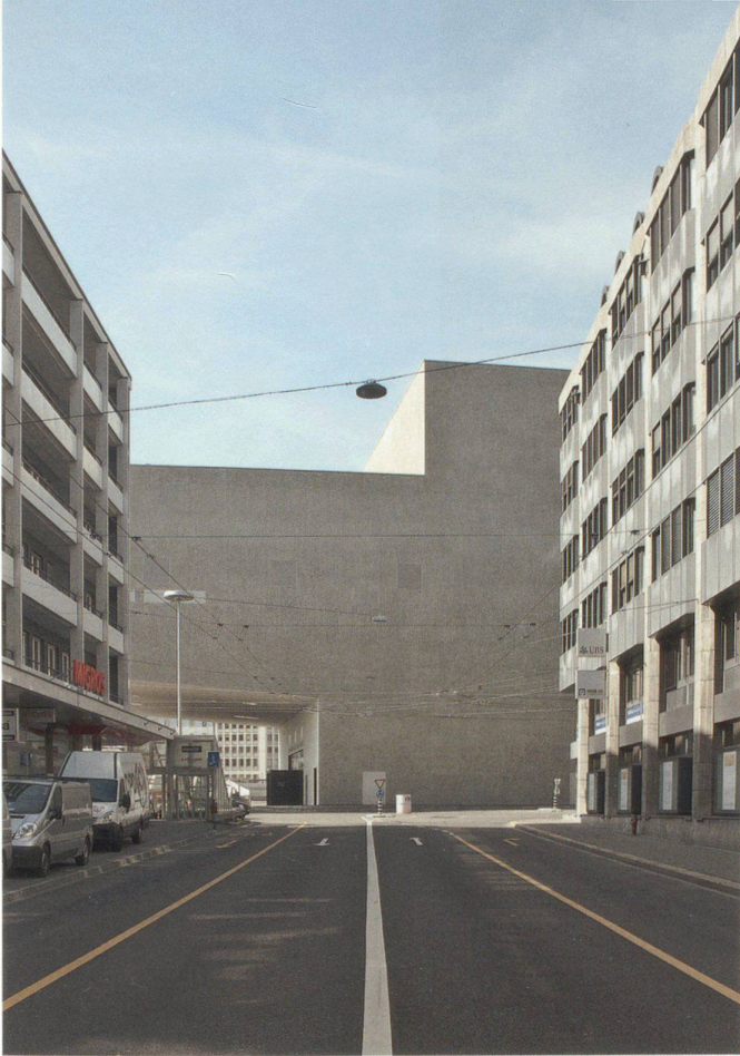
Blick aus der Rue de l'Abbé Bovet auf den Neubau. – Bild: Dürig AG, Guillermo Dürig
