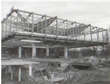
Rückbau bis zum Skelett
