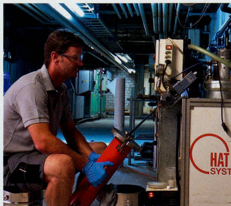
Nach dem Mischen und Dosieren wird das Beschichtungsmaterial in Kartuschen für die eigentliche Innenbeschichtung vor Ort abgefüllt.
