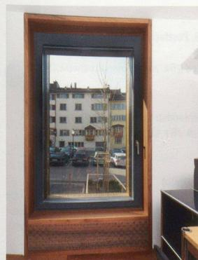
Der innere Abschluss der Kastenfenster bildet eine umlaufende Zarge mit integrierter Brüstung aus Nussbaum furnierten MDF-Platten. Die Brüstungsplatte ist zusätzlich mit Ornamenten ausgefräst, durch welche die Zugluft einströmt.
