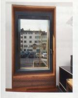
Der innere Abschluss der Kastenfenster bildet eine umlaufende Zarge mit integrierter Brüstung aus Nussbaum furnierten MDF-Platten. Die Brüstungsplatte ist zusätzlich mit Ornamenten ausgefräst, durch welche die Zugluft einströmt.
