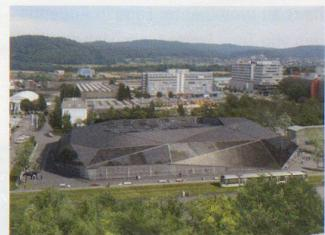
Umwelt Arena demonstrieren, wie Sonnenenergie für die Erwärmung von Brauch- und Heizungswasser sowie zur Stromerzeugung genutzt werden kann. Zusammen mit einem Erdsondenfeld und einer Holzpelletanlage wird so der energiesparende und CO<sub>2</sub>-neutrale Betrieb der Umwelt Arena garantiert. [www.schweizer-metallbau.ch](http://www.schweizer-metallbau.ch) [www.umweltarena.ch](http://www.umweltarena.ch)
