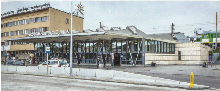
Stadtbahnstation Wschodnia (Ostbahnhof), 1969: Zwei versetzte Faltenreihen mit Oberlichtern
