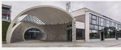
Stadion, 1958: Frei geformte Kalottenschale über dem Tunnel zu den Gleisen
