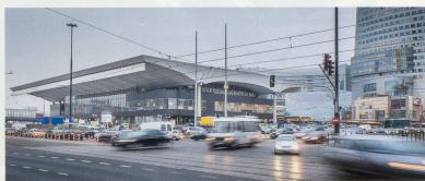
Centralna, 1975: Geschwungene Durchlaufträger auf schlanken Stützen bilden eine «Tischplatte» mit enormer Spannweite.
