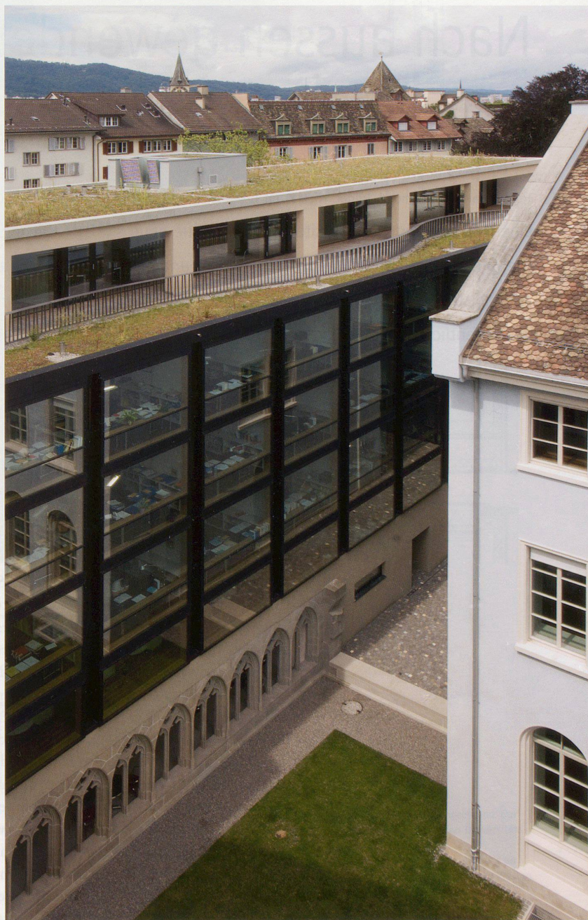
Hofseitige Glasfassade des Ergänzungsbaus
