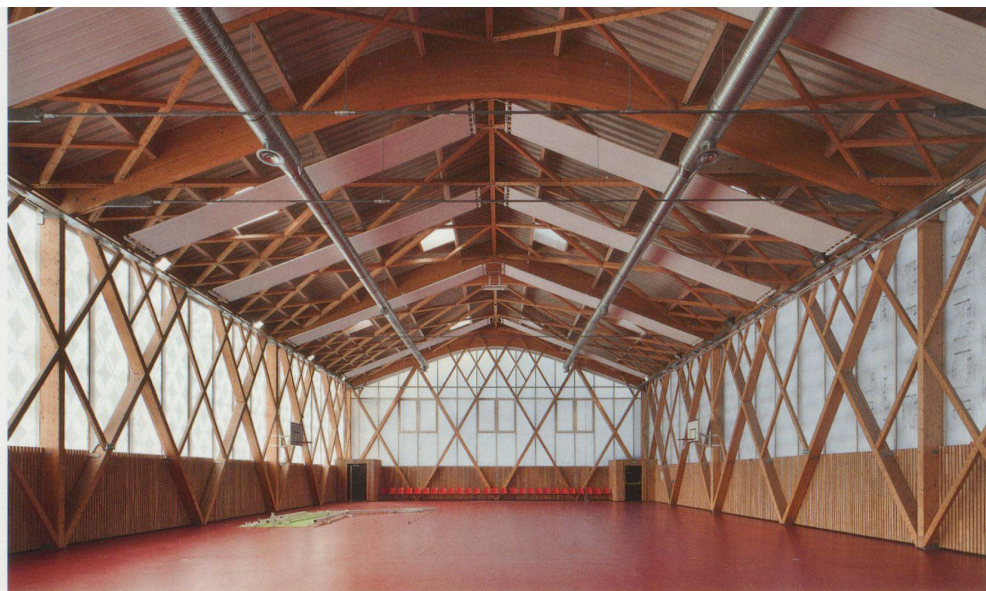
Umriss und Konstruktion der Sporthalle erinnern an die abgebrochene Industriehalle
