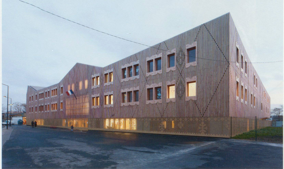
Nordfassade mit Haupteingang: Die Schule besetzt die Ränder des Areals.
