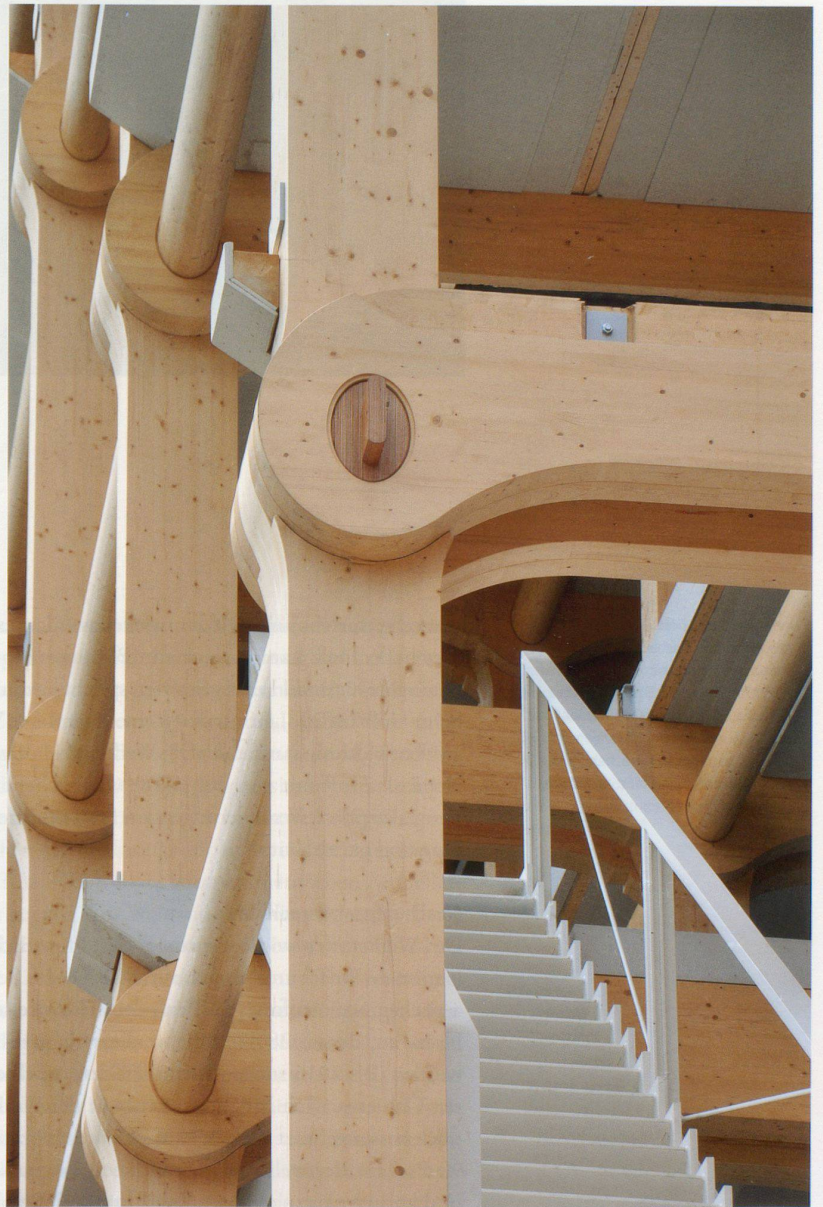
Sichtbare Holzkonstruktion am Tamedia-Neubau in Zürich von Shigeru Ban (im Bau). Das Massivholzskelett mit seinen auffälligen Knoten, in Zusammenarbeit mit Hermann Blumer entwickelt, kommt ohne Stahlverbindungen aus.
