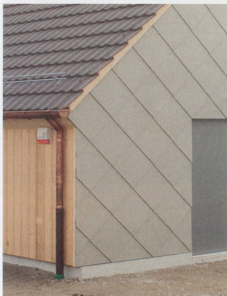
Giebelseite: übergrosse Eternitplatten, Traufseite: Holz
