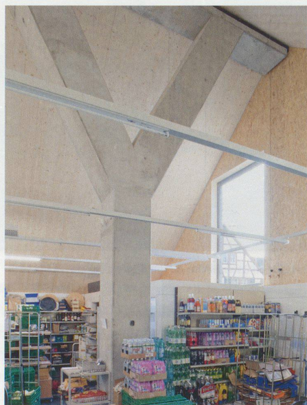
Mächtige Y-Stützen dominieren den Innenraum
